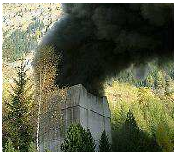
Désenfumage par un puits en cas d'incendie
