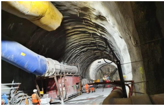
Le climat du tunnel pendant la phase de construction est influencé par de nombreux facteurs
