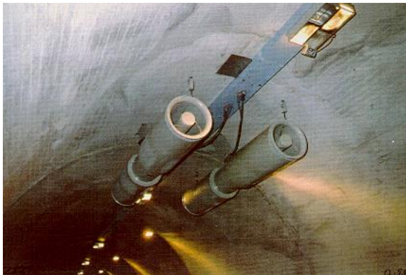
Installazione e allacciamento di ventilatori ad impulso
