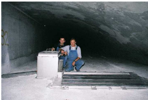
Montage d'un clapet
