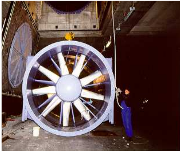
Mise en place d'un ventilateur
