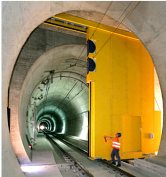
Portone in galleria ferroviaria
