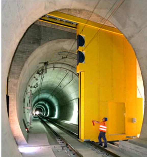
Portail à l'intérieur d'un tunnel ferroviaire
