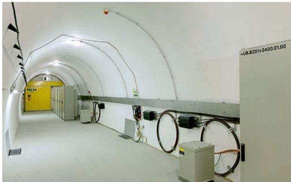
Schaltschränke in einem Querschlag zur Unterbringung der Bahntechnik
