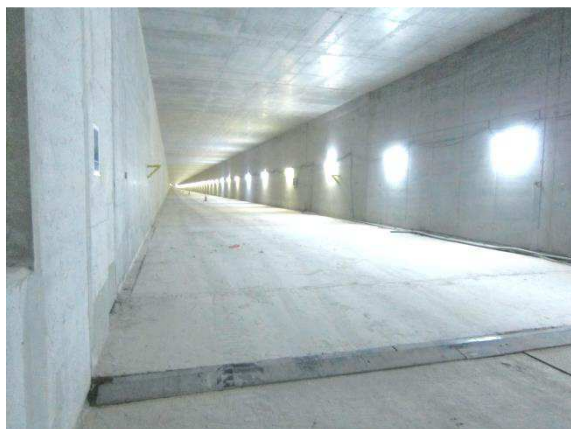
Galleria grezza per la ferrovia urbana di Lusail
