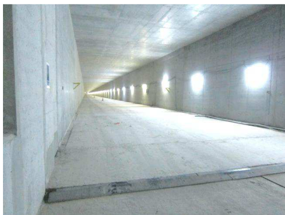
Tunnel en construction du Lusail LRT.
