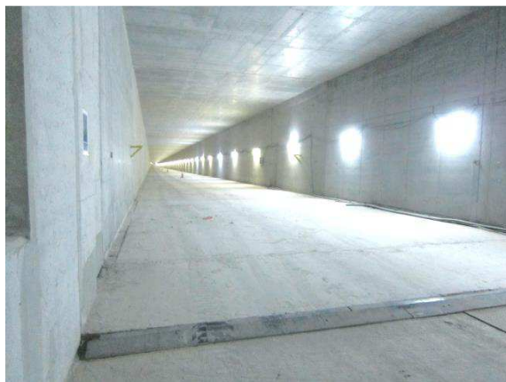
Rohbautunnel für die Stadtbahn von Lusail
