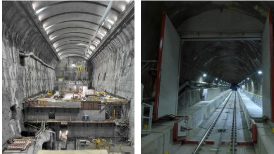
A sinistra: stato della caverna per i macchinari; a destra: galleria di alimentazione dell'impianto della caverna
