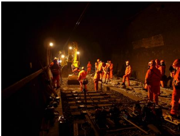
Rimozione ghiaia vecchia utilizzando il Vanoliner
