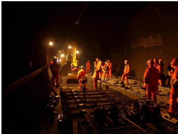
Excavation de l'ancien ballast par Vanoliner
