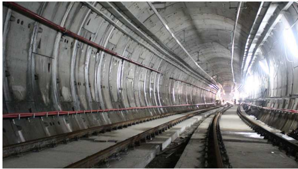
Exemple typique de tronçon de tunnel à un tube à deux voies avant mise en service
