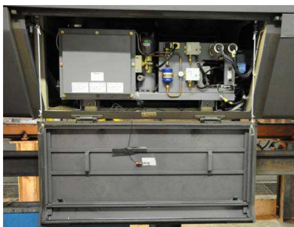
Montaggio di un trasduttore di pressione all'interno del rivestimento laterale
