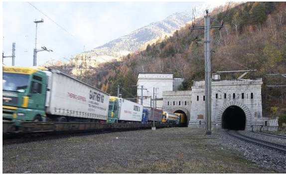
Portale nord della galleria Simplon
