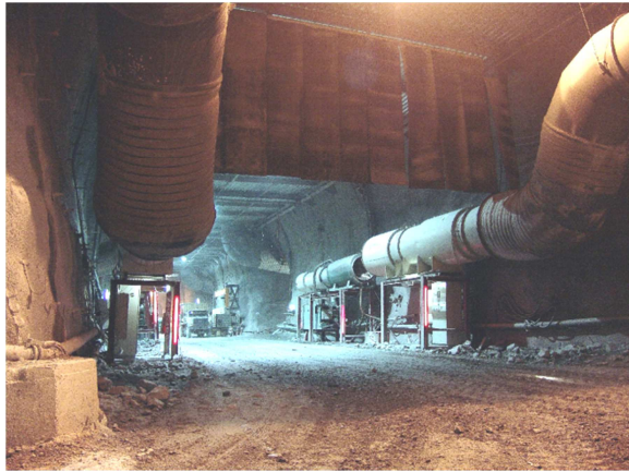
Utilisation de conduits, de ventilateurs et de machines à refroidir pour la ventilation et le refroidissement de la construction
