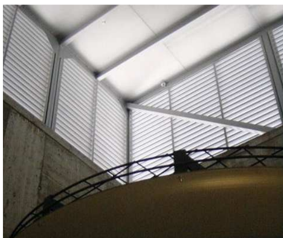
Hotte de protection au-dessus du ventilateur
