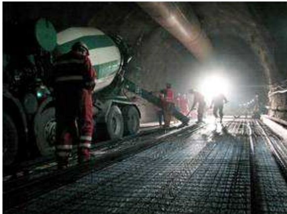
Construction de la dalle de roulage avec utilisation d'une ventilation de chantier
