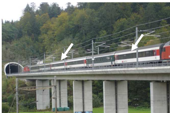
Treno speciale con apparecchiature di misurazione durante l'ingresso nella galleria Murgenthal (le frecce indicano la posizione degli apparecchi di misurazione)
