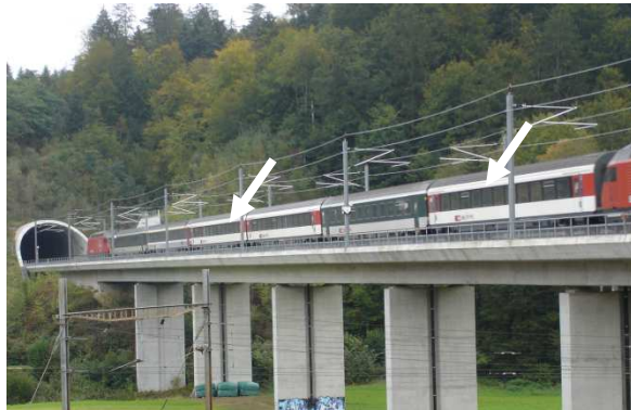
Tunnel de Murgenthal (les flèches représentent les points de mesures)
