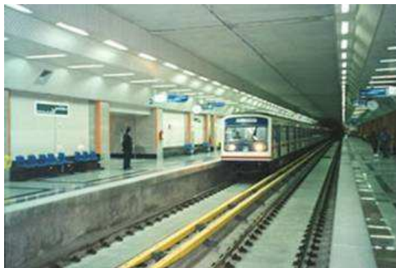
Stazione metro con marciapiedi laterali (Teheran)
