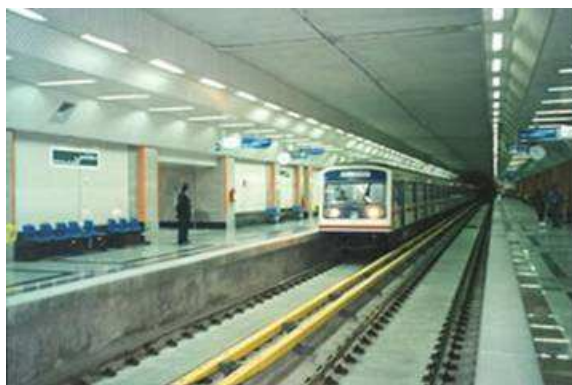
Station de métro avec perrons latéraux (Tehran)
