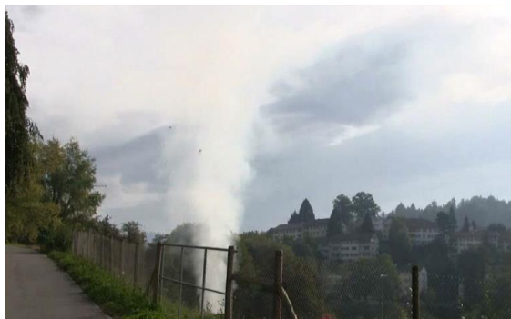
Refoulement des fumées par la cheminée du système de ventilation
