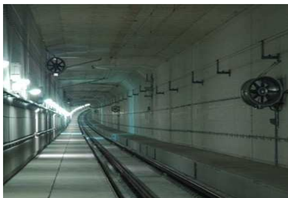
Tunnel Dordtsche Kil
