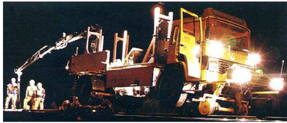
Lavori di manutenzione
