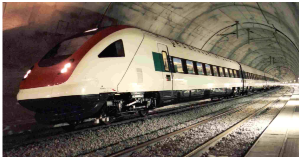
Transito di treni ad alta velocità in galleria (qui il treno ICN nella galleria Grauholz) con elevati carichi di vento e di pressione
