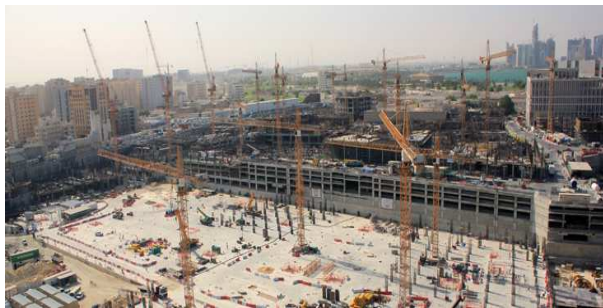
Lavori di costruzione della stazione Msheireb
