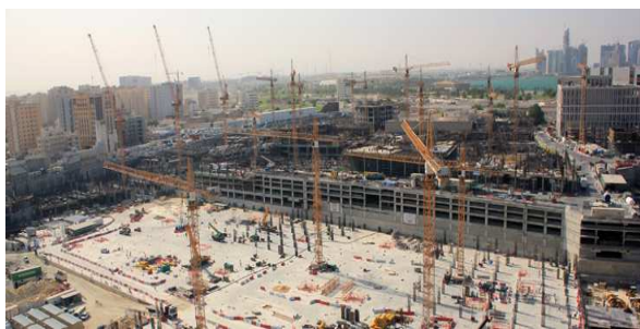
Travaux de construction de la station Msheireb
