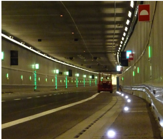
Weströhre des Tunnels
