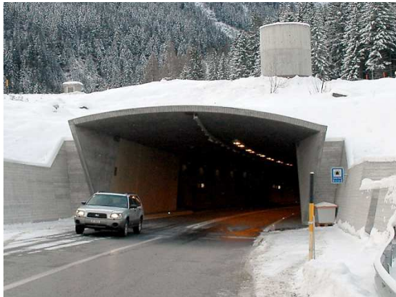
Portal mit Abluftkamin
