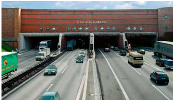
Nordportal des Elbtunnels mit vier Röhren
