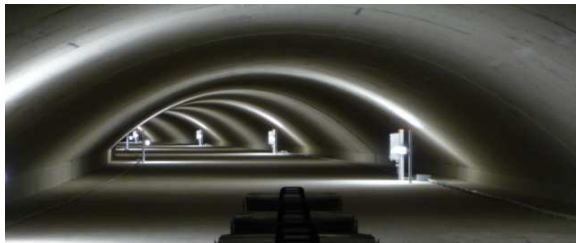
Abluftkanal 1. Röhre Ortbeton nach dem Umbau
