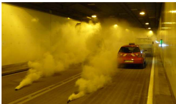
Kaltrauchversuch während der Inbetriebnahme
