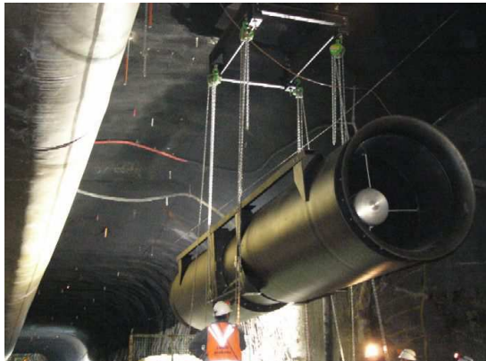
Montage eines Strahlventilators
