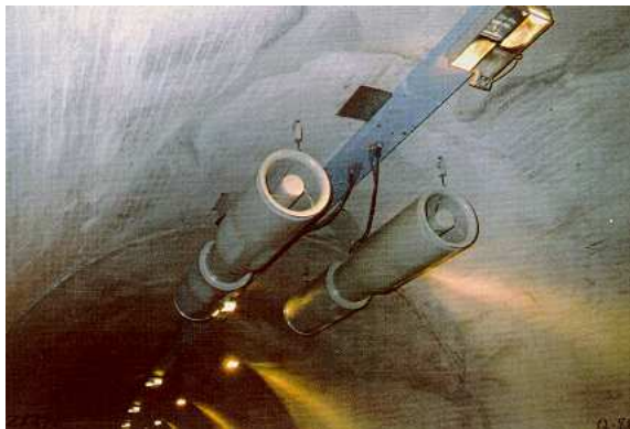
Installation und Anschluss von Strahlventilatoren
