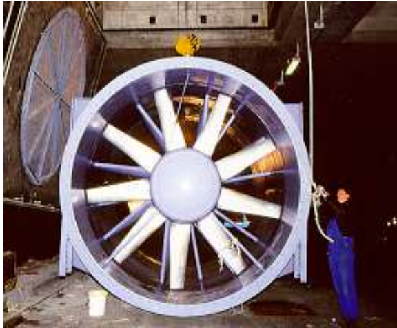
Montage eines Axialventilators
