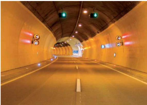
Fahrraum des Ambergtunnels nach Sanierung
