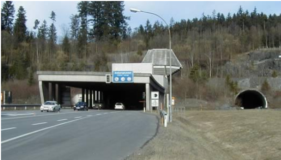
Portal des Ambergtunnels
