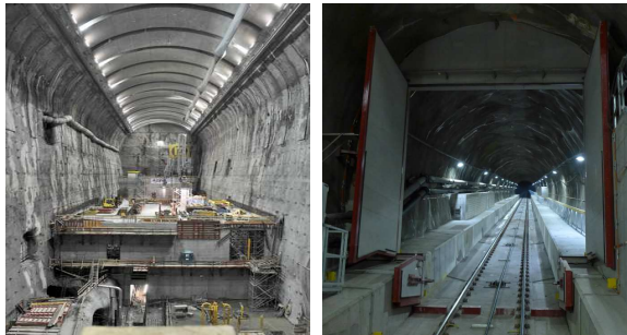
Links: Bauzustand der Maschinenkaverne; Rechts: Versorgungsstollen der Kavernenanlage
