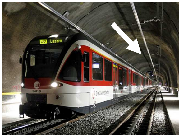
Ventilatore in acciaio della ventilazione d'emergenza all'incrocio sud
