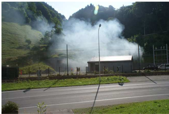
Rauchaustritt aus Südportal bei Rauchversuch
